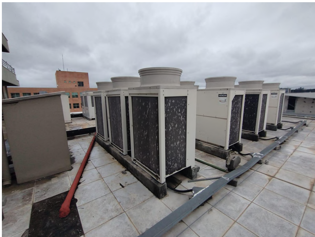
Condensadoras e base de concreto
