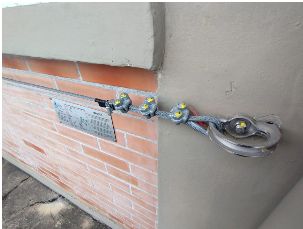
Linha de vida para remoção - Terraço
