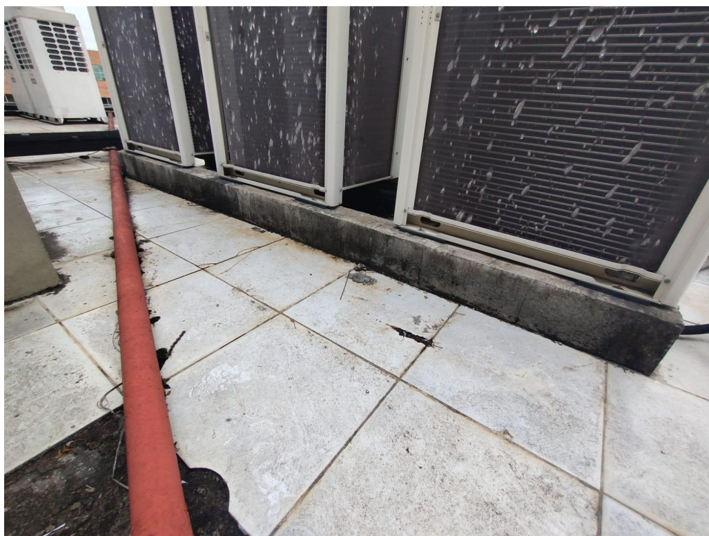
Base de concreto das condensadoras
