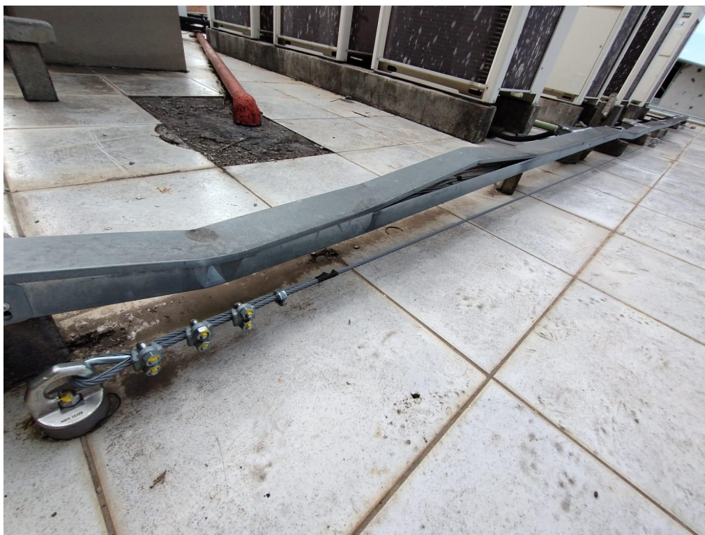
Linha de vida para remoção - Terraço
